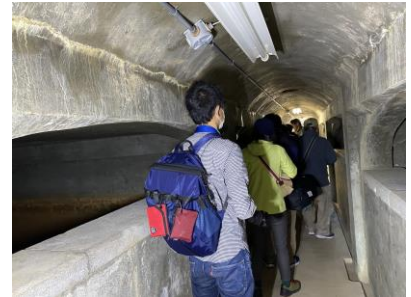
旧配水池の内部（多米配水場）
