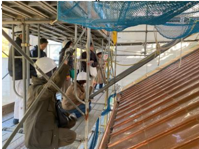
修復工事の様子（豊橋ハリストス正教会）
