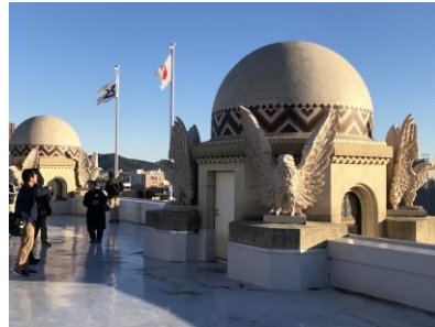
屋上（豊橋市公会堂）
