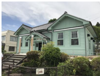
旧伊深村役場庁舎外観
