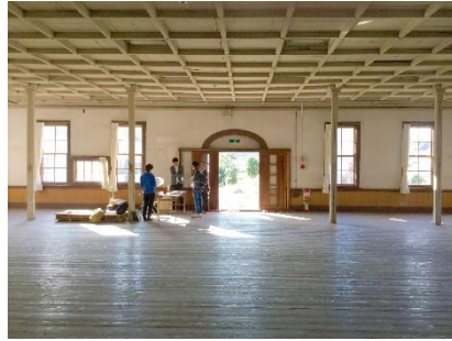
内部の様子（旧愛知県第二尋常中学校講堂）
