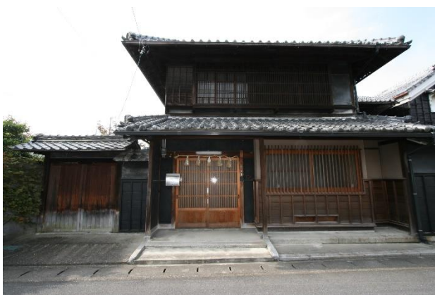
旧堀田廣之家住宅外観
