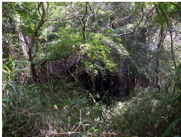
平成 17 年発掘時の第 3 トンネル
