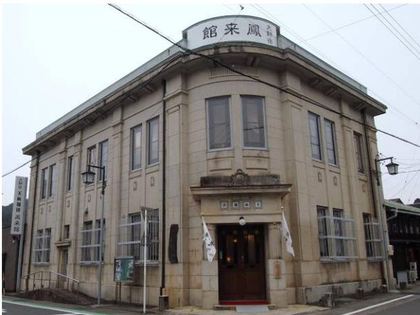
鉄筋コンクリートの内部は木造 2 階建
