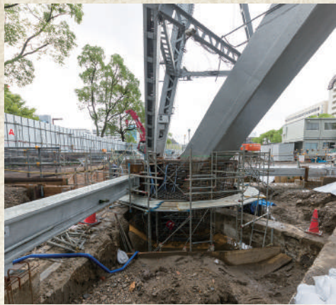
免震工事中の柱の基礎部
