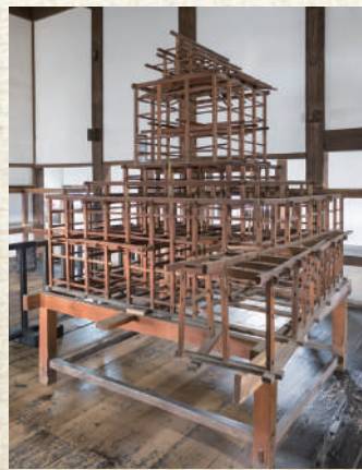
軸組模型。天守の構造がよくわかる
