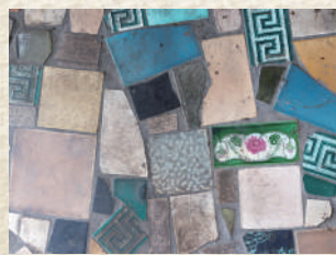
乱張りされたタイル
