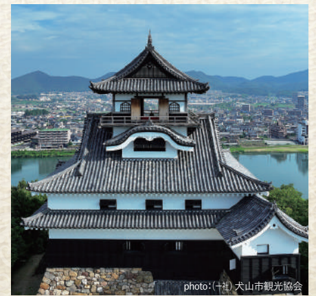
望楼外観。棟には約1.2mのシャチホコがのる
