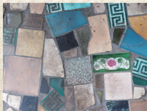
乱張りされたタイル
