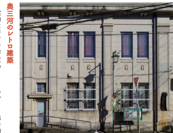
南側の外観。柱間や柱の幅に注目
