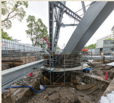
免震工事中の柱の基礎部
