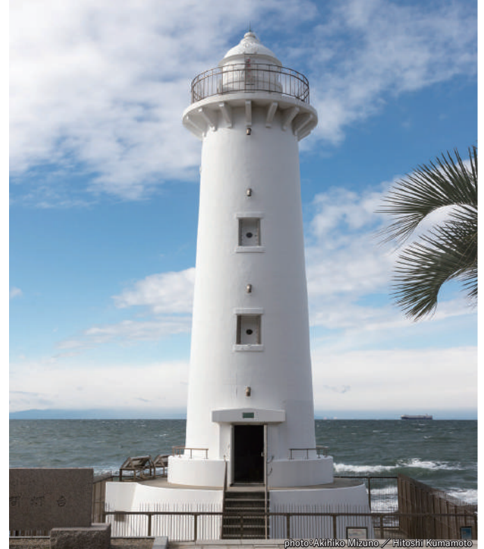
灯台の全景。2 mの基礎部から19 mの灯台が伸びる。伊勢湾とたたずむ素晴らしい風景
