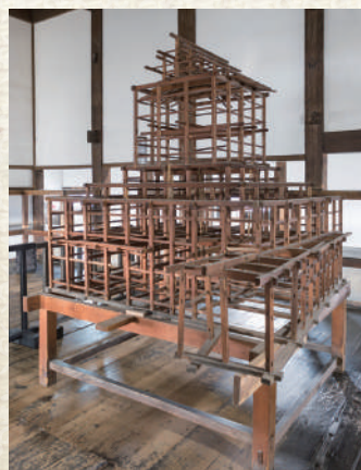
軸組模型。天守の構造がよくわかる
