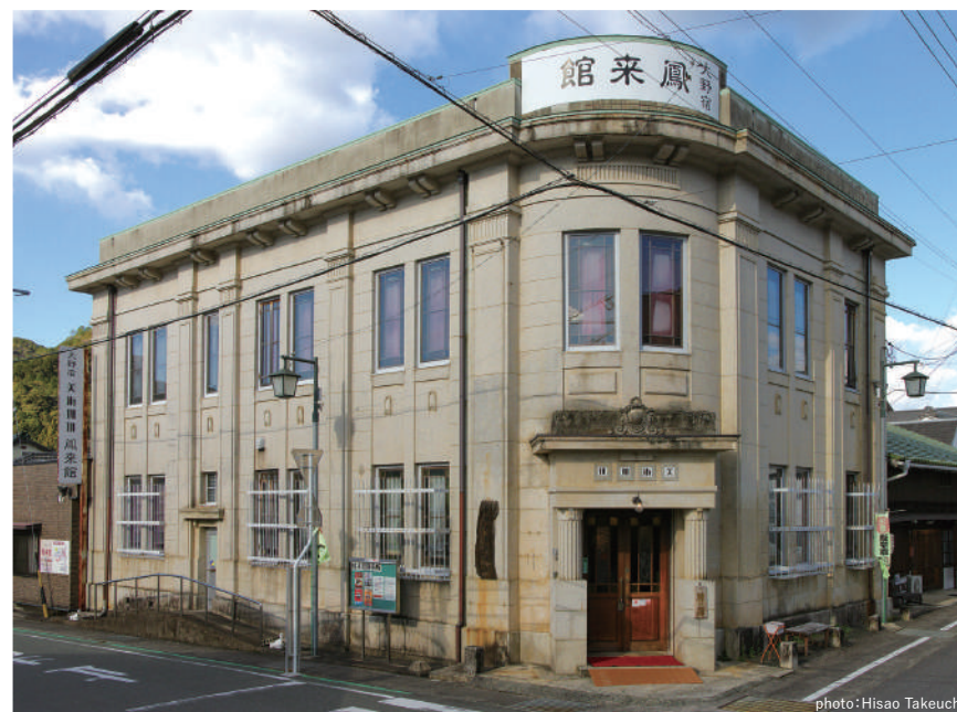
旧街道沿いの町並みに溶け込む外観。角地を逆手にとった古典主義様式の構成が巧み
