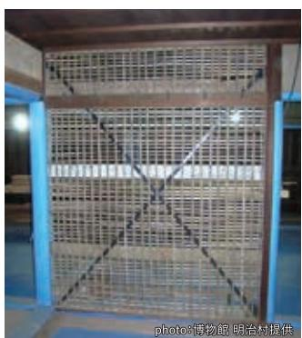
西園寺公望別邸「坐漁莊」の耐震補強金物、昭和の増改築時に施されたと考えられる。当時から補強を見せない工夫が施されている
