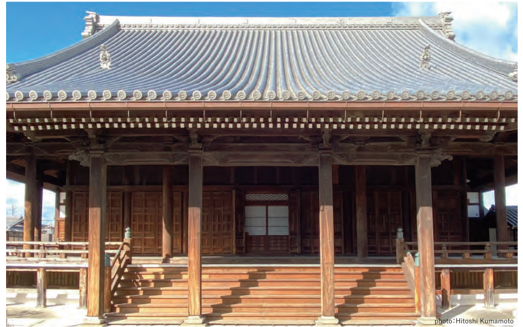
本堂正面。軒下の空間が広々と透けていてとても気持ちいい
