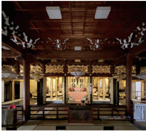
本堂内観。虹梁の上にのる組物に注目
