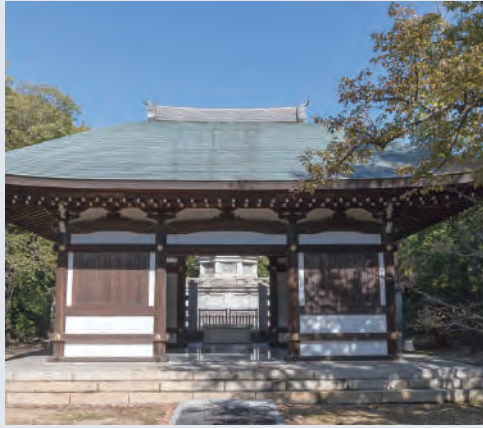
礼拝殿。通天門ともに伊藤平左衛門十世の作
