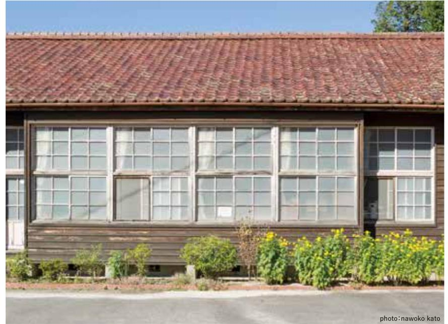
出窓の構成。教室内により多くの光と空気を採り込む工夫
