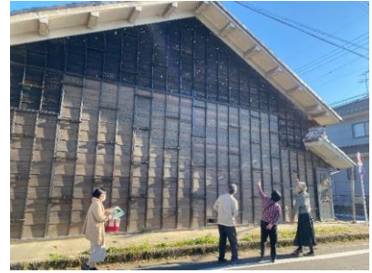
クラファン資金で修復された西壁（旧奏屋）
