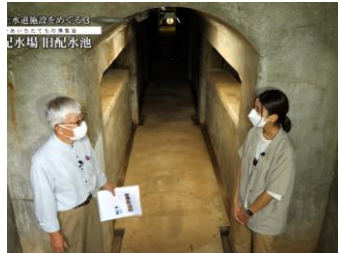
多米配水場(11/11) 上水道施設その3。かつての配水池は半地下で神秘的な雰囲気。現貯水タンクからの眺めも良い。
