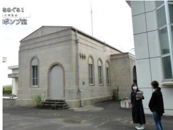
下条取水場(11/9) 上水道施設その1。豊川から水を汲み浄水場まで圧送する役割がある。その道中の水道橋も紹介。
