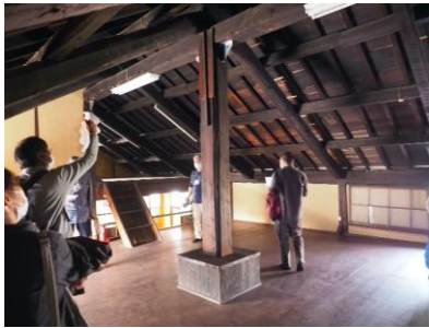
2階に上がり大黒柱を見る(旧堀邸家)
