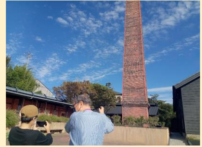
改修された高さ22mの煙突(窯のある広場)
