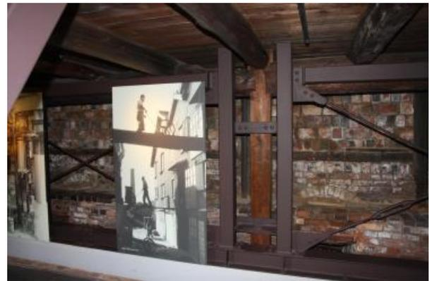
鉄骨柱や梁や筋交いによる耐震補強
