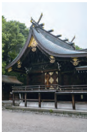
白砂に浮かぶ本殿
