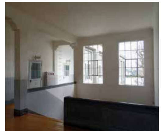
2階たまり。踊り場のスチールサッシュの窓に注目
