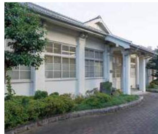
外観。正面の屋根には千鳥破風が載る
