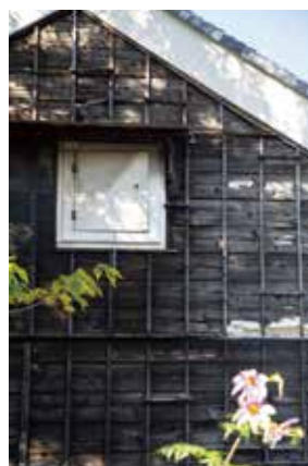
東側の下見板張りの外観
